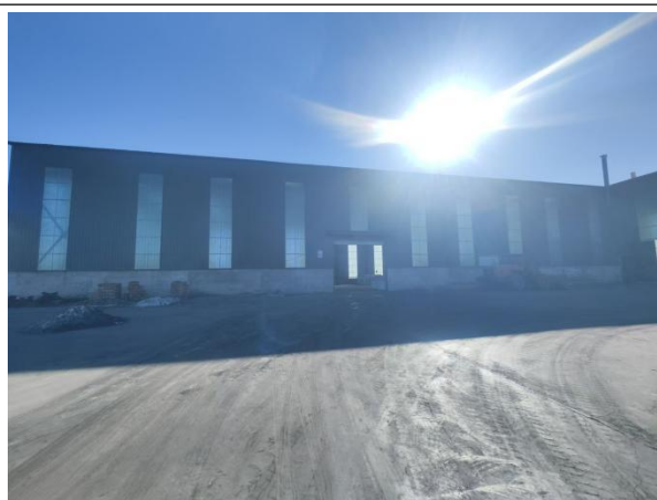
封闭生产车间
