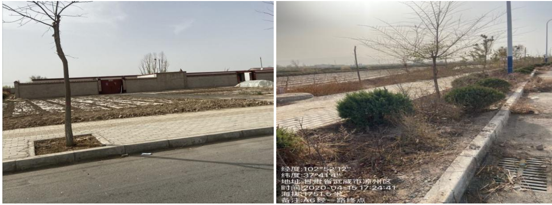
图6.6-1 排水设施和边坡防护
